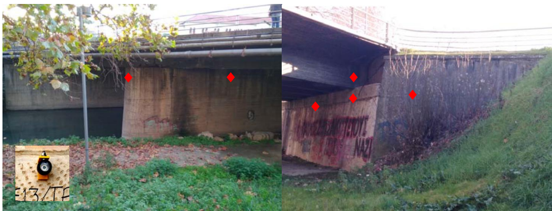
Εικόνα 7 Οπτικά πρίσματα (optical prisms, κόκκινο)
