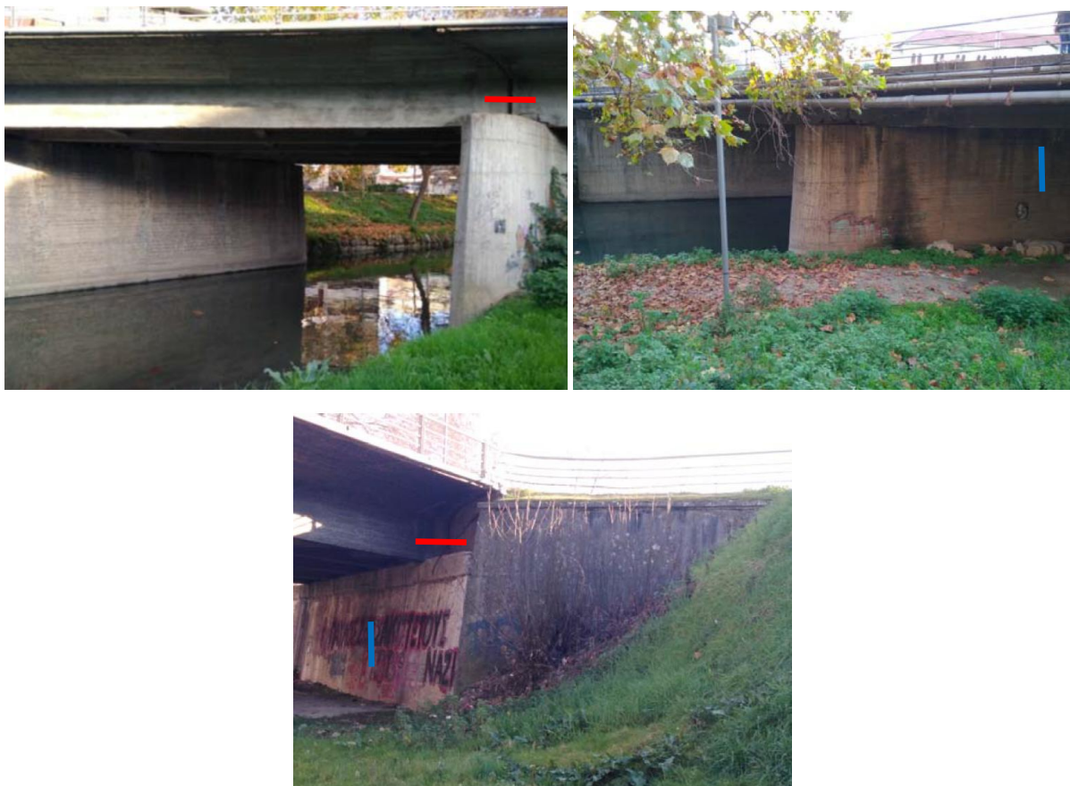
Εικόνα 2 Τοποθέτηση μετρητών ανοίγματος αρμών (joint meter, κόκκινο) και μετρητών κλίσης (tilt meter, μπλέ)
