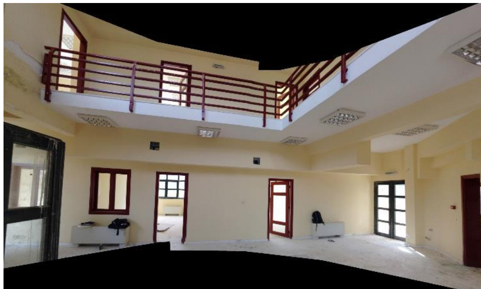
Όψη του εσωτερικού στην είσοδο του κτιρίου.
