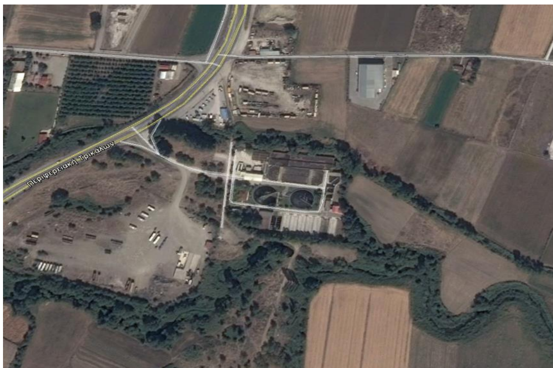
Εικόνα 1-29 Βιολογικός Καθαρισμός της πόλης των Τρικάλων
