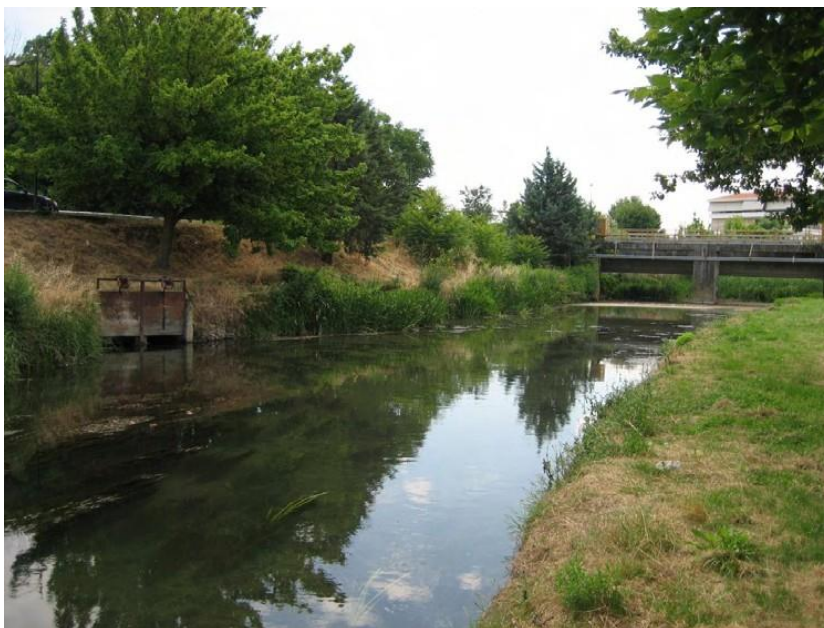
Εικόνα 3. Παλιό χωμάτινο φράγμα με μεταλλικό ρουφράκτη στην βάση του (αριστερά) & νέα γέφυρα Αρριανού (δεξιά) - Ανάντη οπτική
